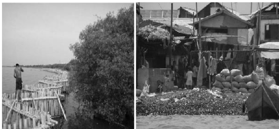
Gambar 19. Contoh Penanggulangan Pantai Cara Tradisional Dengan Menggunakan Sekat Pantai Dari Pancangan Bambu (Dari Bengen 2011).
