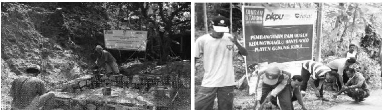
Gambar 4. Masyarakat Bergotong Royong Membangun Pondasi Tempat Penampungan Air. Sumber : Dokumentasi PKPU (2015).
