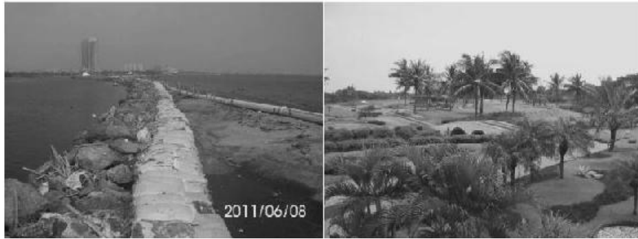
Gambar 25. Penanggulan Lepas Pantai Ancol Dalam Rencana Reklamasi Pada Sebagian Perairan Pantainya Yang Akan Dilakukan (Foto Dari Kushariadi).
