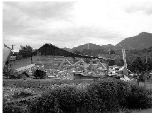
Gambar 5. Kerusakan Bangunan di Desa Tapak Muge, Kecamatan Kute Panang, Kabupaten Aceh Tengah. Pada Latar Belakang Terlihat Beberapa Titik Longsor.
