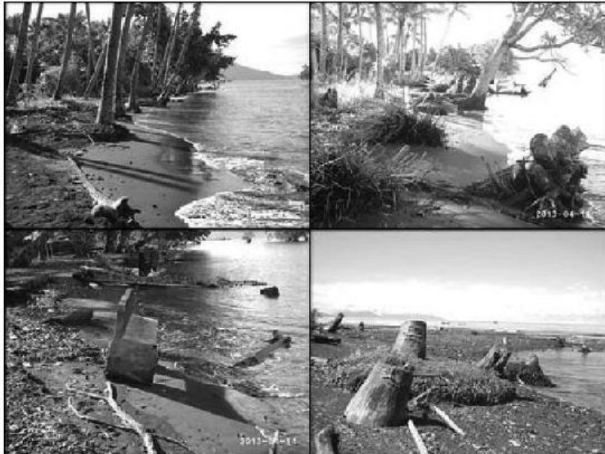
Gambar 1. Kerusakan di Pantai Kastela Akibat Erosi Marin.
