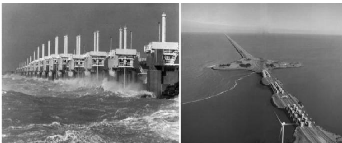
Gambar 23. Storm Surge Barrier di Oosterschelde, Belanda Untuk Melindungi Negara tersebut dari Hempasan Gelombang Badai Yang Mengenai Pantainya dan Penggenangan Air Laut ke Daratannya (USACE 2008).
