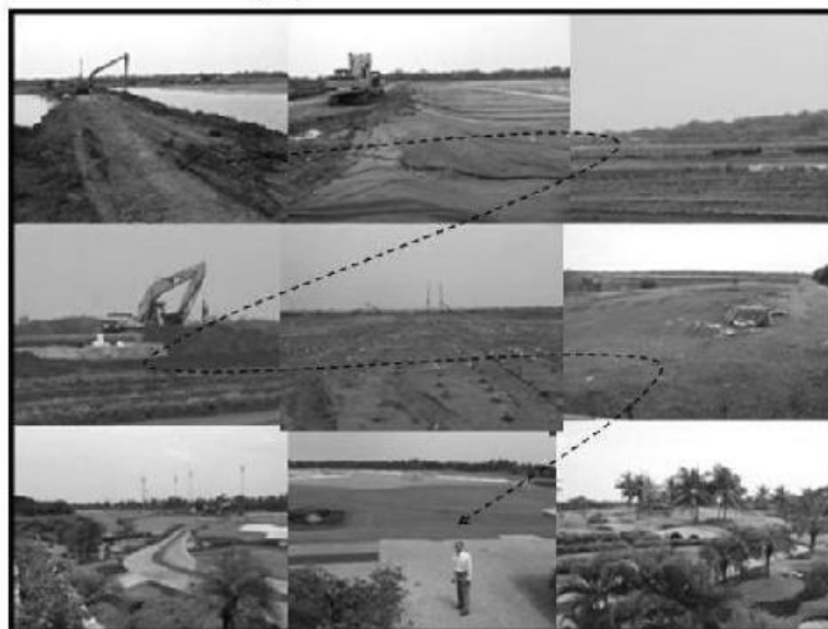
Gambar 27. Urut-Urutan Kerja Cara Reklamasi Dengan Sistem Polder di Pantai Indah Kapuk, Jakarta Barat Sebagai Cara Yang Umum Diterapkan di Belanda Dalam Memperoleh Lahan Rendah Kering Air.
