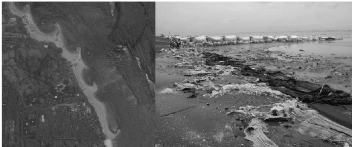
Gambar 16. Contoh Cara Keras/Struktur Dengan Membangun Tanggul Pantai Groin Tipe J dan Y di Bali, Gambar 17. Contoh Cara Semi Lunak Dengan Groin Menggunakan Geobag atau Geotube yang Terbuat Dari Material Dari Geotextile di Pantai Daerah Kabupaten Krawang, yang Kurang Berhasil Dalam Menghadapi Erosi Pantai
